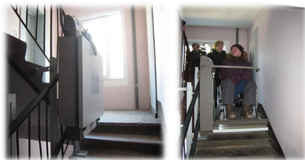
Pacēlājs Valdeķu ielā 68 k.2
